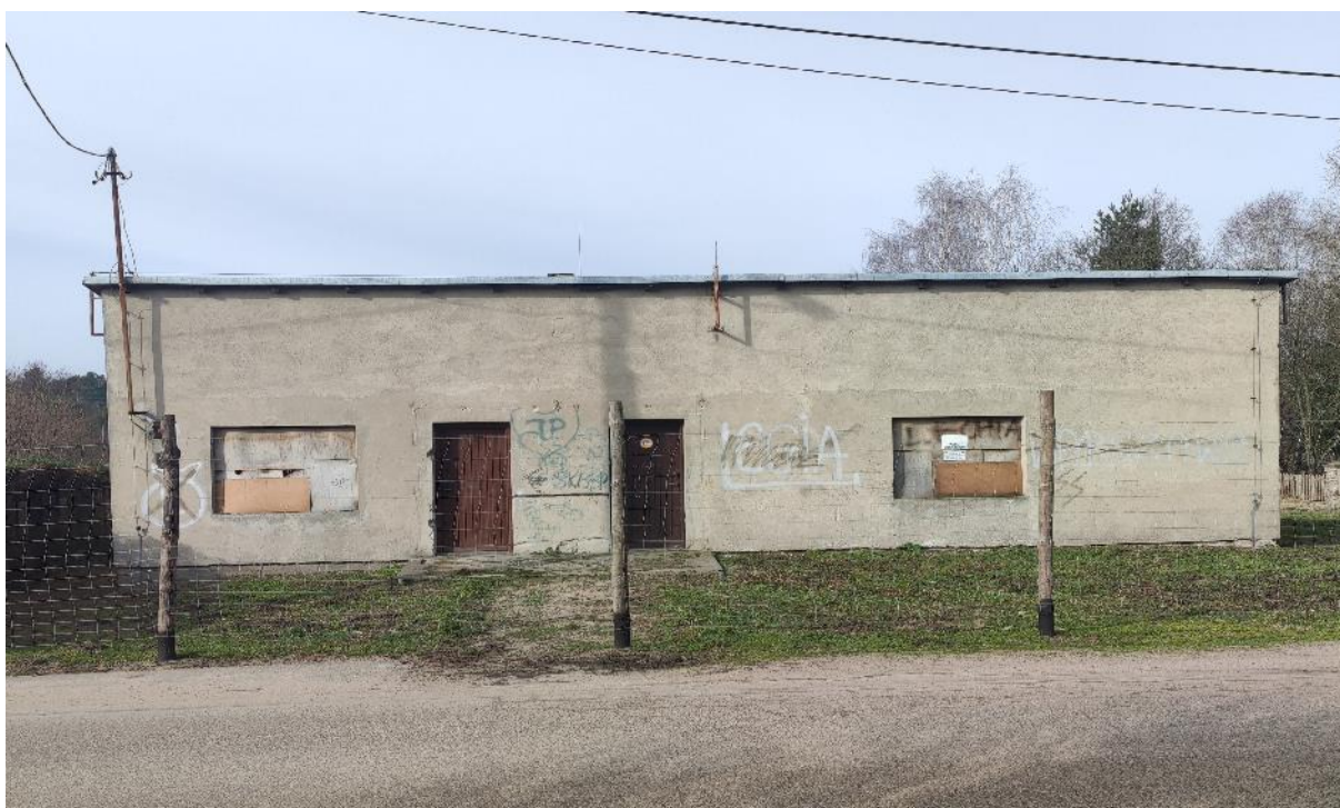
Zdjęcie 37 Budynek dawnej świetlicy osiedla Krajewo (2022 r.)
